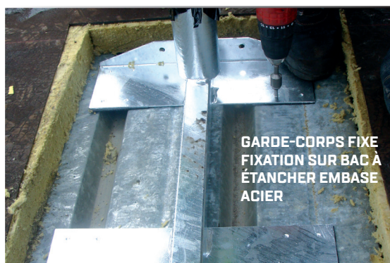
GARDE-CORPS FIXE FIXATION SUR BAC À ÉTANCHER EMBASE ACIER
