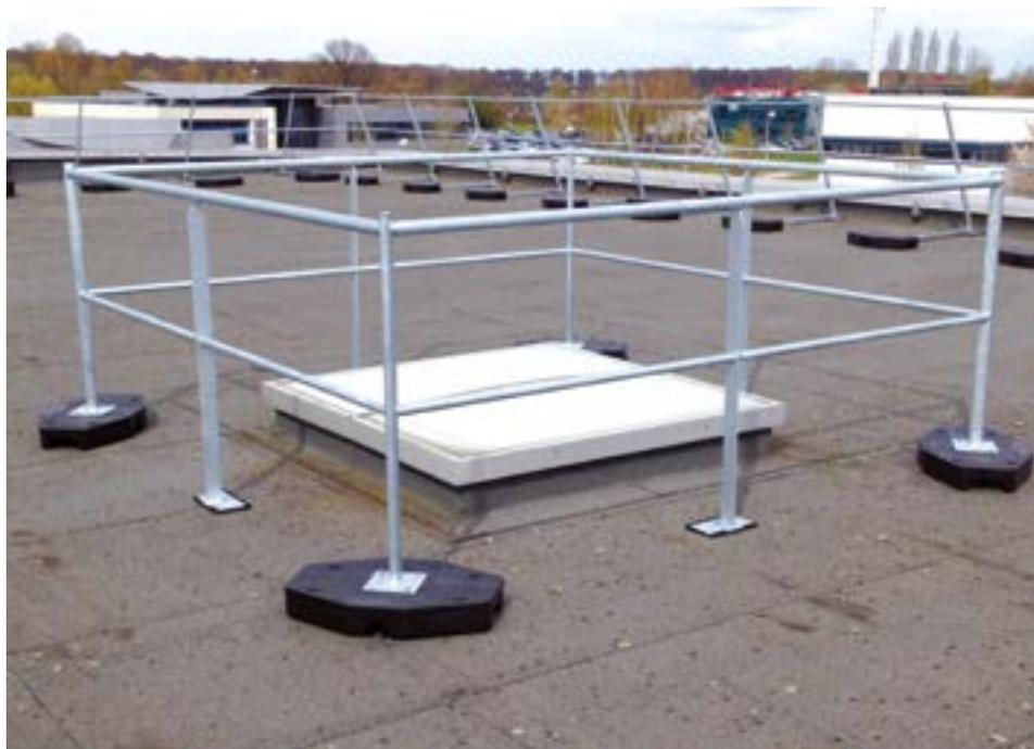
Barrières autoportantes, spécialement conçus pour protéger contre les chutes de hauteur (lanterneaux, exutoires, éclairages zénithaux).
