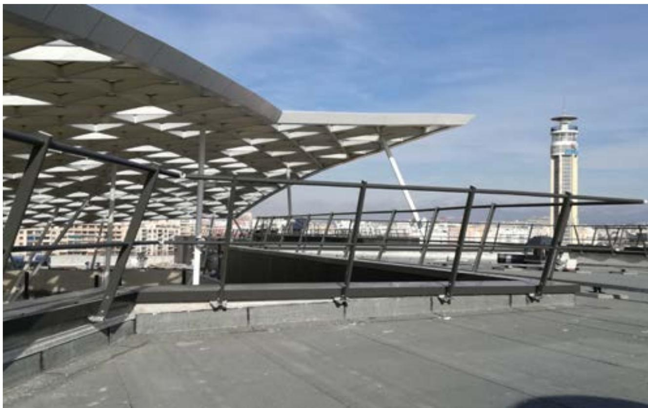
Gamme complète de garde-corps fixes, lestés ou rabattables en acier ou en aluminium conformes aux normes **NF E 85-015 et EN ISO 14122-3**.
