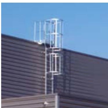
Les échelles à crinoline SECURIGARD® permettent l'accès aux terrasses, bâtiments et installations industrielles. Chaque échelle est composée de modules et d'une échelle simple (sans crinoline). Elles sont ensuite équipées d'une sortie et d'un passage d'acrotère. Uniquement conçues pour l'accès aux zones protégées.
