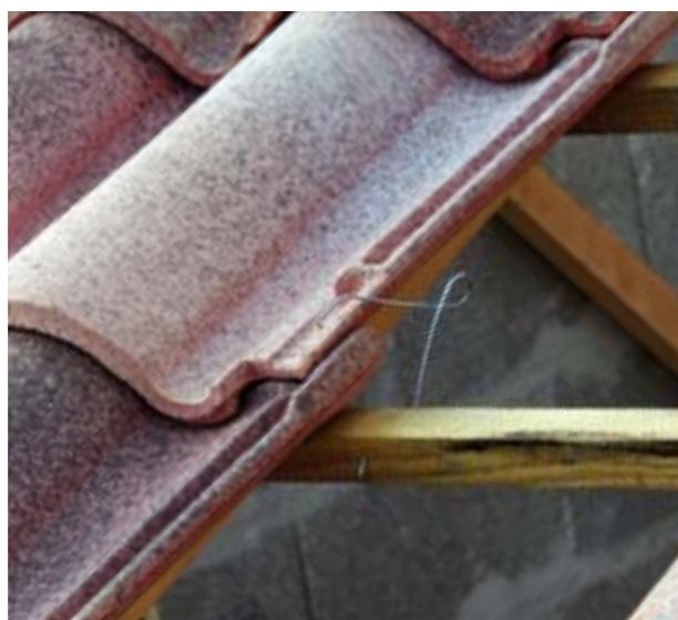
Suite aux dernières tempêtes et les dégâts occasionnés sur les couvertures en tuiles, la NV 65 a été modifiée entraînant une réédition du D.T.U. 40.21. Le respect de ce D.T.U. est une obligation car les assureurs exigent qu'un édifice soit réalisé selon le D.T.U. pour une prise en charge sous le régime de la garantie décennale.
