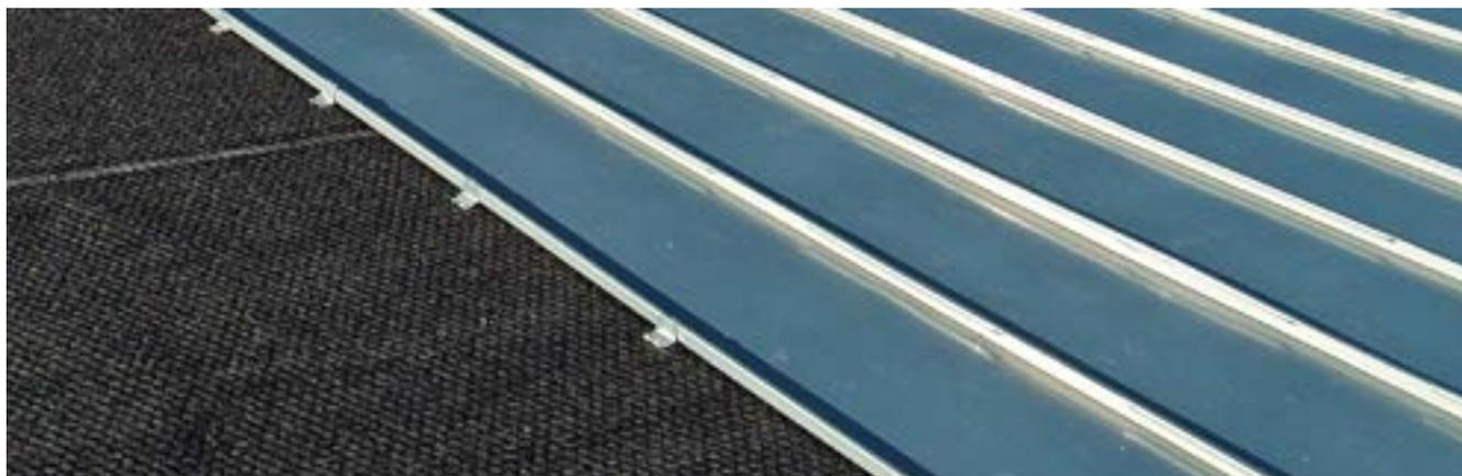
La patte de rive est destinée à fixer les éléments de rive d'une toiture en zinc. Elle se fixe à l'aide de pointes ou de vis Ø4mm maximum.
