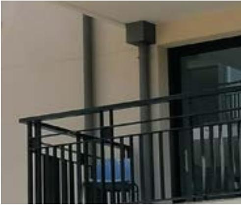
Les boîtes à eaux acier carrées FRENEHARD, fabriquées en France et garanties 10 ans, sont d'un design épuré et assurent un recueil optimal de l'eau. En acier galvanisé revêtu par thermolaquage après fabrication, elles vous garantissent une belle finition et une parfaite durabilité y compris en zone agressive.
