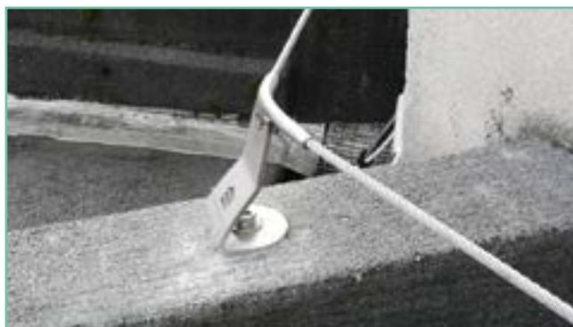
Le passage des potelets intermédiaires se fait sans se détacher à l'aide d'un chariot ou en se détachant avec un mousqueton.
