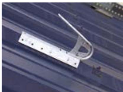
**EN CAS D'UTILISATION DE L'ÉCHELLE DE TOIT SANS LE CROCHET DE FAITAGE, L'ÉCHELLE DOIT ÊTRE IMPÉRATIVEMENT MAINTENUE PAR UN CROCHET DE SÉCURITÉ CONFORME À LA NORME NF EN 517.**
