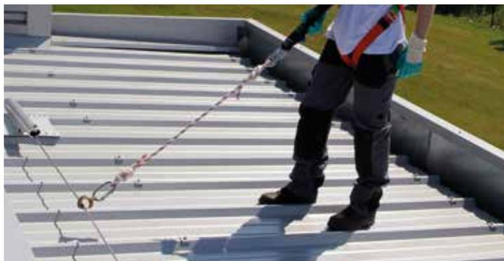
La ligne de vie est un support d'assurage flexible horizontal en acier inoxydable, qui s'utilise en installation à demeure. Elle s'adapte à tous types de parcours et de supports à l'aide d'ancres structurales (potelets, ancrages de façade,...) en acier galvanisé à chaud.
