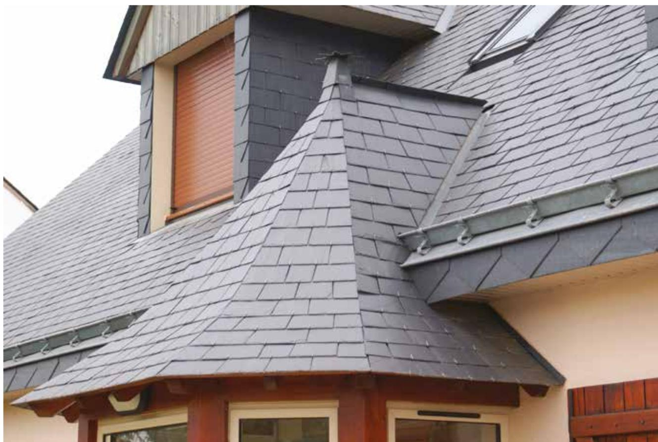
Conformément au DTU 40.11, les crochets dont la longueur est supérieure ou égale à 12 cm sont automatiquement livrés en crosinus
